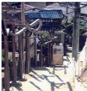
図2.斜面市街地に設置された簡易型リフト
