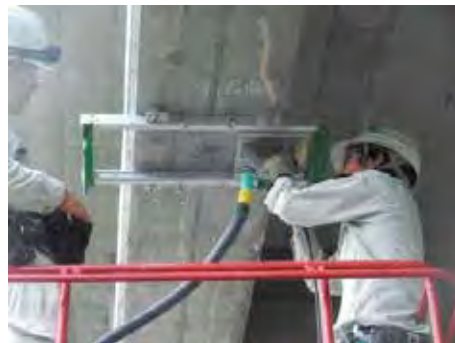
(写真-2) スリット切削状況
