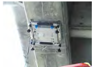
(写真-3) 画像撮影状況
