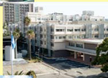
工学部本館2期改修 (H20. 3完成)
