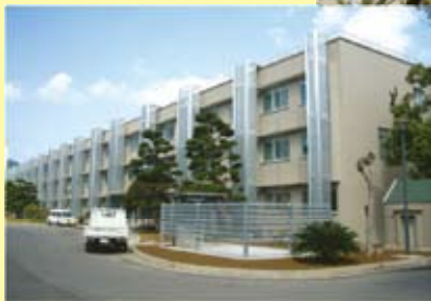
水産学部本館改修 (H20. 3完成)
