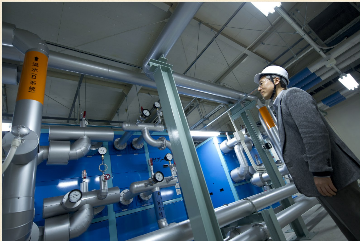
バイナリー発電所の内部を見渡す馬越先生。温泉水の熱で沸点の低い液体を沸騰させ、その蒸気が発電機のタービンを回す力になります。
